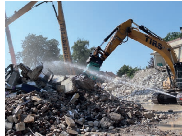
Ein Longfront- und ein Abbruchbagger nahmen die Gebäudemontage an der Barckhausenstraße vor.
